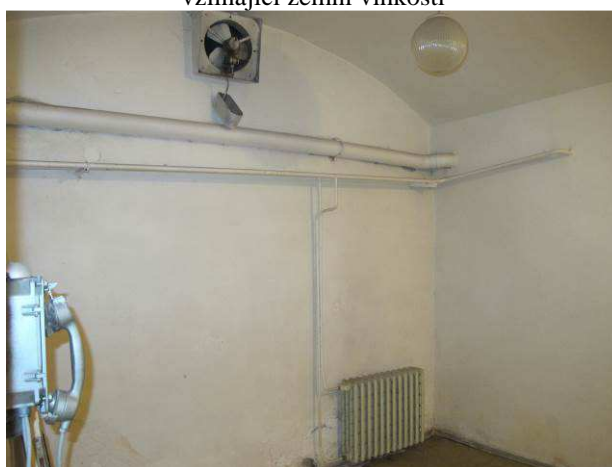
Foto č.28 – pohled na nefunkční odvětrávání suterénních prostor
