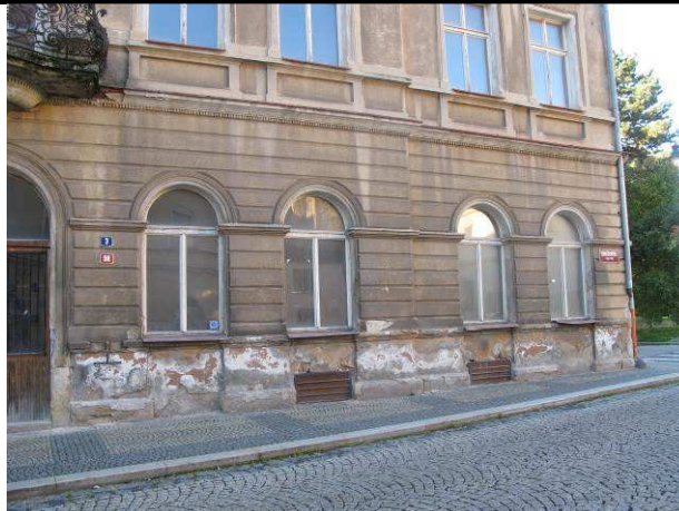
Foto č.2 – vlhkostní projevy na fasádě především v soklové části
