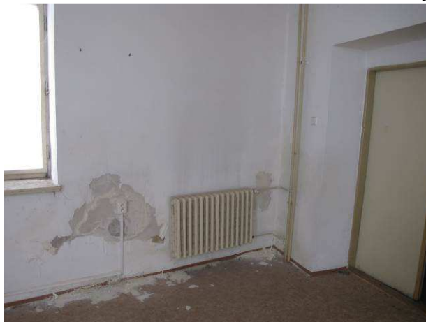
Foto č.14 – projevy vlhkosti v přízemí na jižní obvodové stěně
