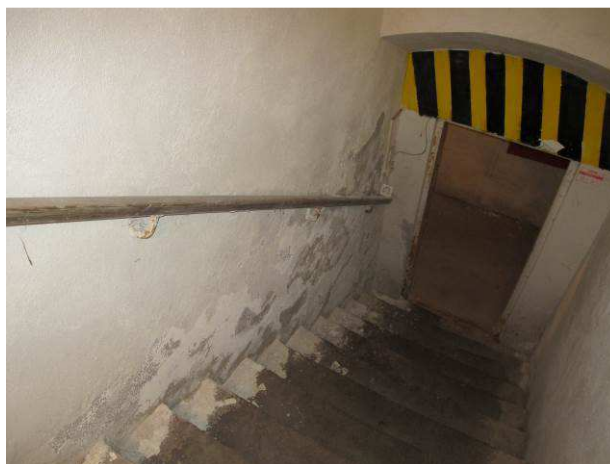
Foto č.18 – vlhkostní projevy na vnitřní schodišťové stěně
