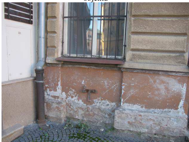
Foto č.3 – dešťové svody osazené lapači splavenin
