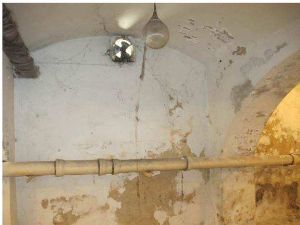
Foto č.25 – pohled na nefunkční odvětrávání suterénních prostor
